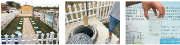
图9 多台净化槽串并联系统的示范工程(50 t/d)
