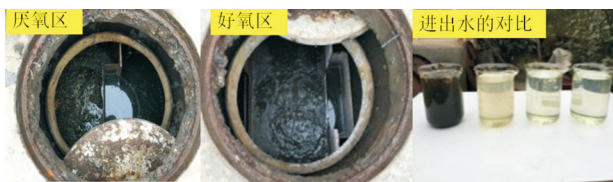
图3 净化槽实际运行7年的处理效果图
